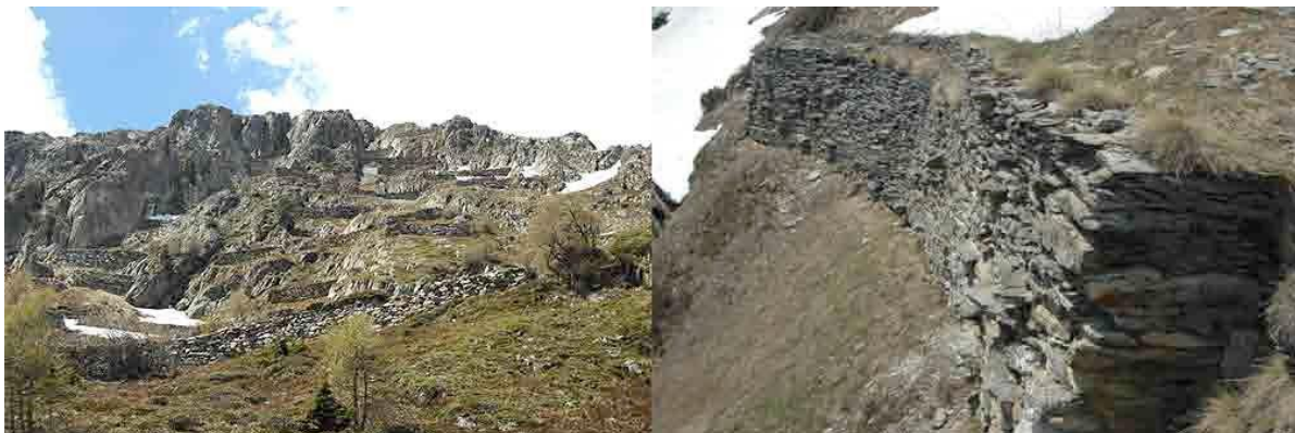
Trockensteinerrassen als Lawinenverbauungen ob dem Bahnhof Goppenstein (Foto P. Salzmann, 2004)
